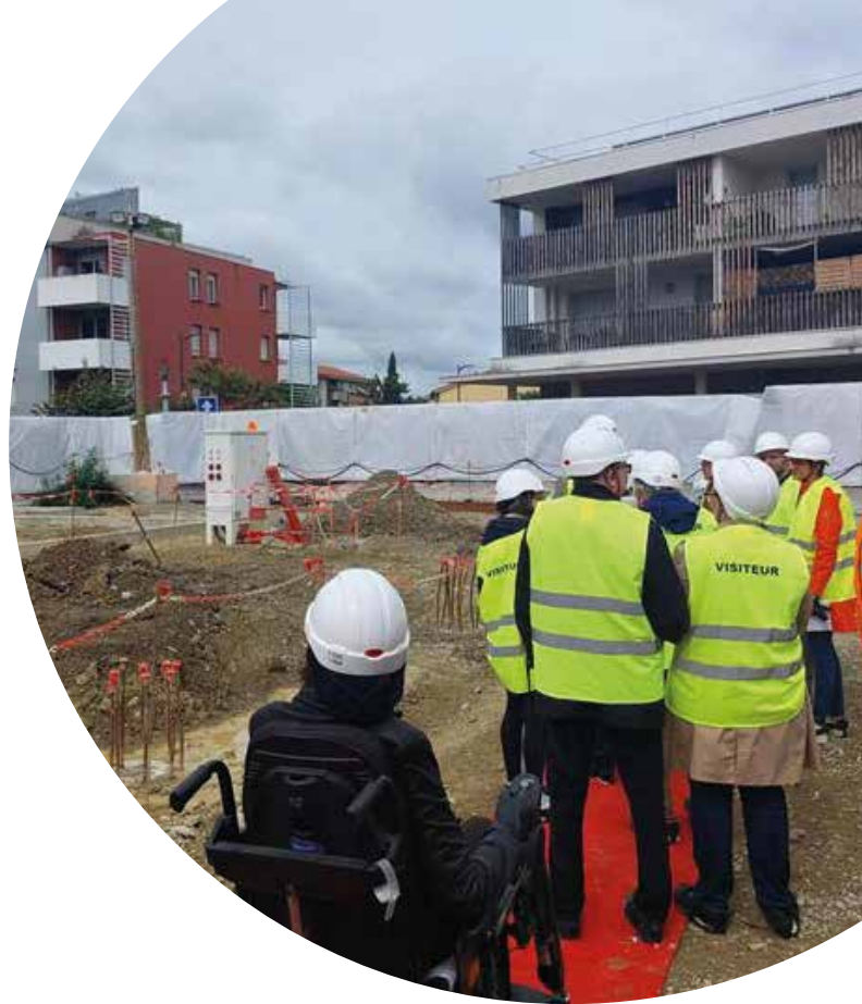
Visites de chantier avec une dizaine de riverains. Au programme : présentation du projet ligne C et visite du chantier des futurs puits Ferdinand Faure et Balansa.
