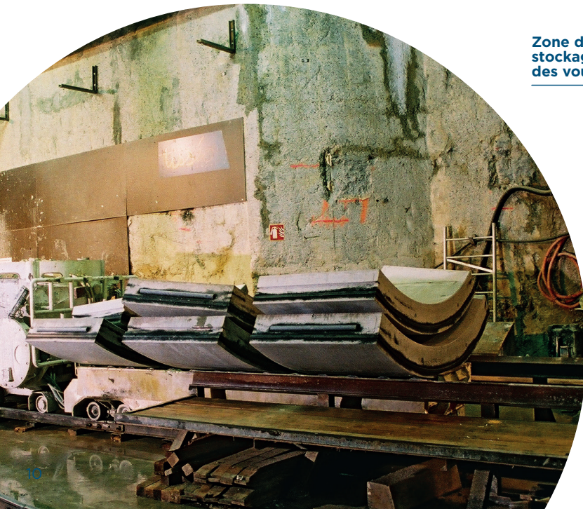
Chariot amenant les voussoirs qui composeront les parois du tunnel
