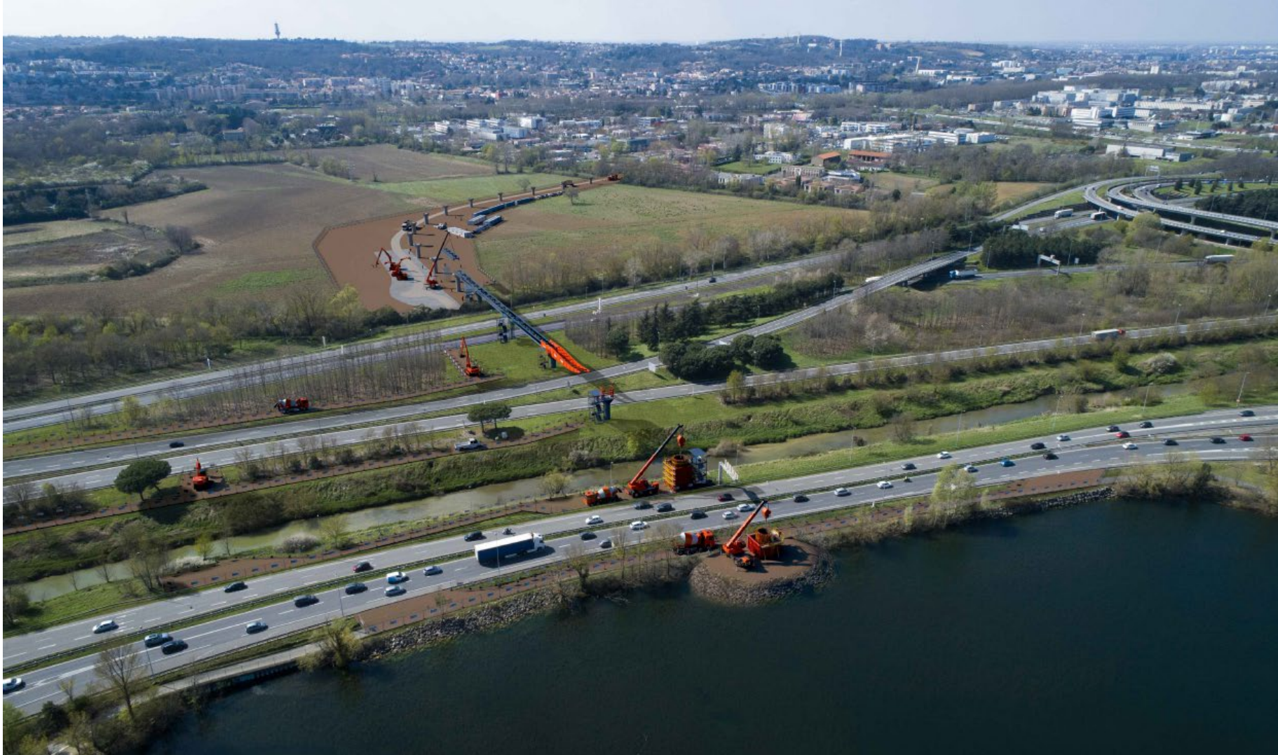
Des fermetures ponctuelles de l'autoroute de nuit durant l'automne
